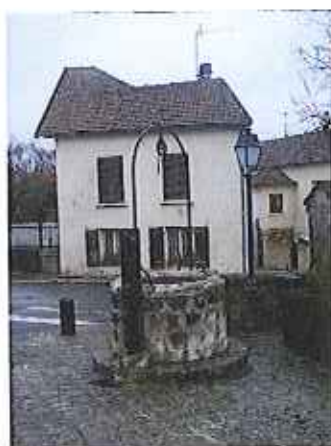
Photo 4 : Le puits et la pompe
