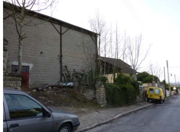
Espace de retrait entre le hangar et la voie
