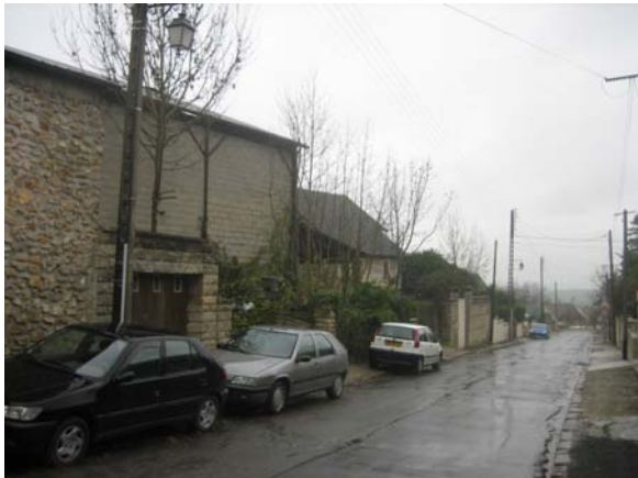
Garage et hangar en parpaing
