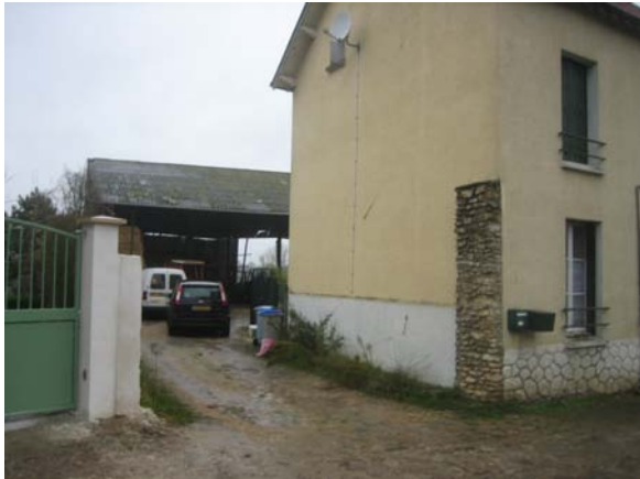
Bâti ancien réhabilité à l'alignement et accès sud
