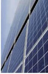
Un panneau solaire ou capteur solaire est un dispositif destiné à récupérer une partie de l'énergie du rayonnement solaire pour la convertir en une forme d'énergie utilisable. La meilleure orientation est plein sud et la meilleure inclinaison, pour une utilisation sur une année entière, est d'environ 45°.
