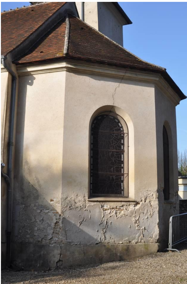
Restauration de l'église Notre Dame de la Pitié (1 ère tranche) Montant total HT : 53 000.00€
