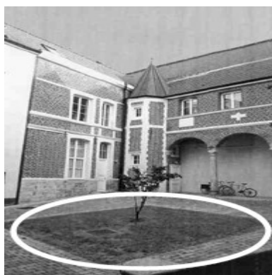
Puits d'infiltration (Source : ADOPTA)
